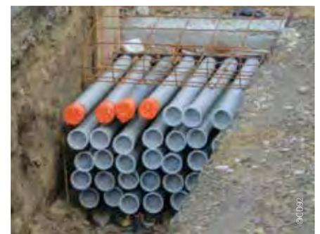
C'est grâce aux tuyaux enterrés sous la voirie que les stations de votre tramway seront alimentées en électricité et que l'information voyageurs sera transmise. Ces tuyaux sont regroupés en fourreaux rassemblés dans des cubes de béton. On appelle ces chambres de câblage des multitubulaires. Elles se situent d'un seul côté de la plateforme et longent la ligne dans toute sa longueur. La réalisation de ces ouvrages représente une opération majeure du chantier.
